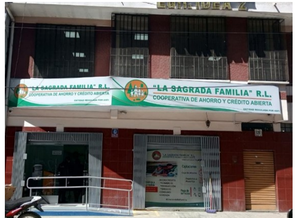
AGENCIA "EL ALTO" Calle 13 N° 170, entre Av. 6 de Marzo y Calle Alfredo Franco Valle (Edificio Idea2) Telf. 2-820501, 12 de Octubre – El Alto.
